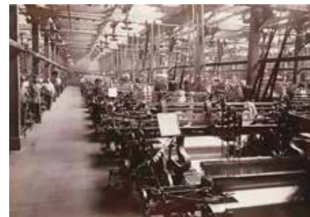
織り機の自動化にはベルトが重要な役割を果し発展した（大正時代）
